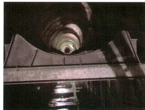
Kanalizační sedla a nosníky zaměřované laserovým paprskem
