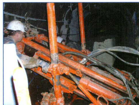
Vrtání kolektorových chrániček
