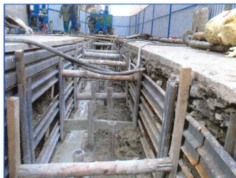
Zajištění objektu ZUŠ
