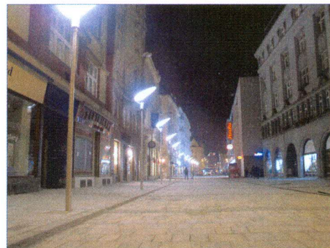
Rekonstrukce chodníků na ulici 28.října
