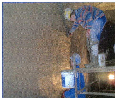
Nanášení izolační vrstvy Vandex
